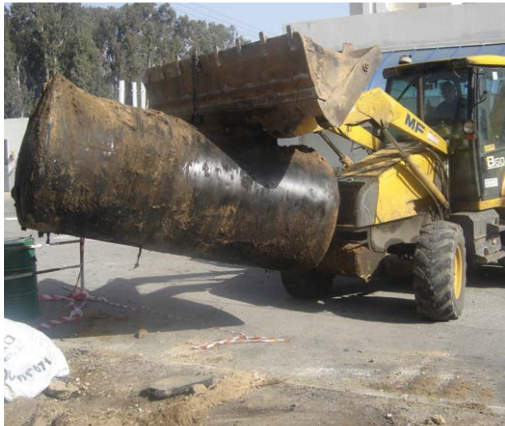
הוצאת מיכל דלק טמון והתקנת מערכת טכנולוגית מתקדמת לטיפול בקרקע ומי תהום
