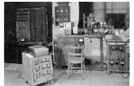
איור 3: מערך הסימולציה האנלוגית שבה נבחנה מערכת ההנחה והניהוג
